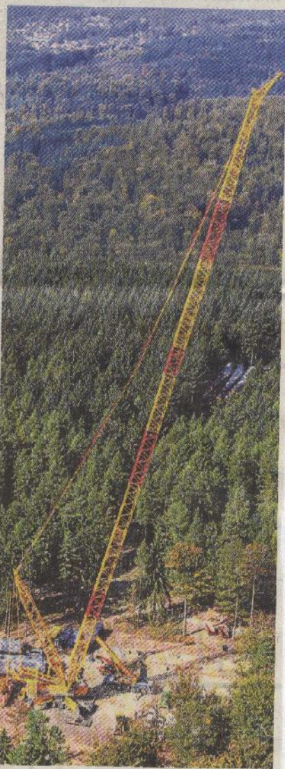
Wolkenkratzer: Die Baustelle an den Vier Fichten aus der Vogelperspektive. Im Hintergrund: Breitenborn. Foto: Häsler
