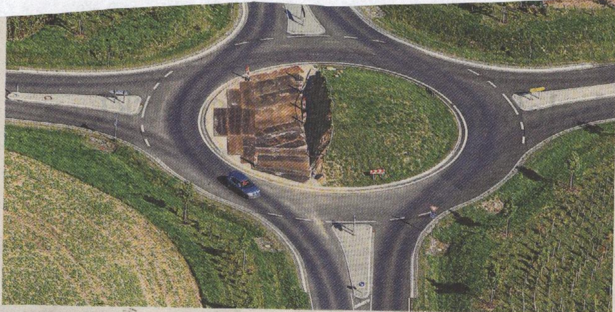
Freie Bahn: Für den Transport der Windräder-Bauteile ist der Kreisel in Gettenbach teilweise eingeebnet worden. Foto: Häsler
